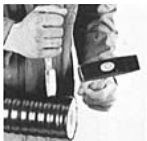
5 Mantel längs aufschneiden. Messers max. 5 mm tiefe stecken.
