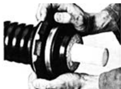
8 Mauerdichtring montieren. Spannschellen anziehen (falls vorhanden).
