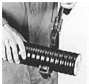
2 Mantel im Abstand X, (Z) vom Rohrende, mit Rohrschneider oder Säge durchtrennen.
